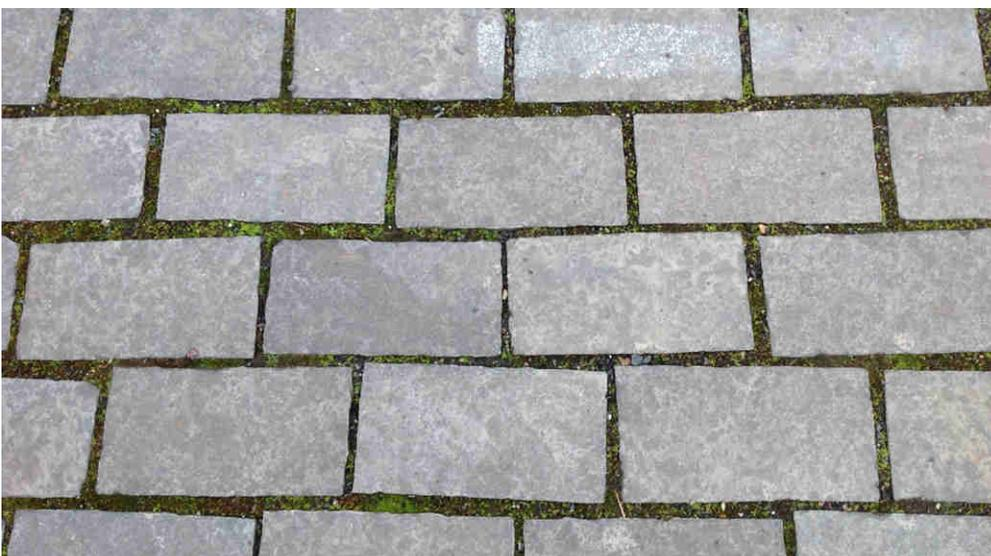
Basaltstein mit gesägter Oberfläche im Reihenverband
