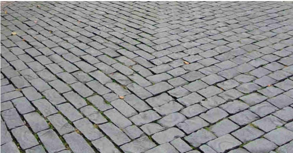
Basaltstein mit spaltrauer Oberfläche im Diagonalverband
